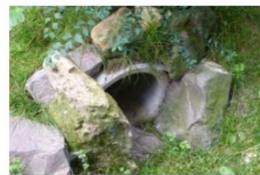
Foto 2.2-25 Kleve: Betonröhre (Foto: N.Reiser)
