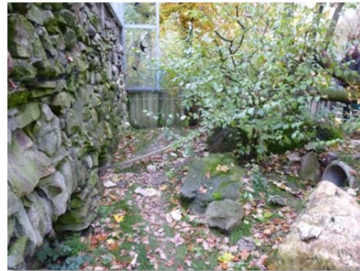
Foto 2.2-24 Kleve: Gehege - Eingang Stall (Foto: N.Reiser)
